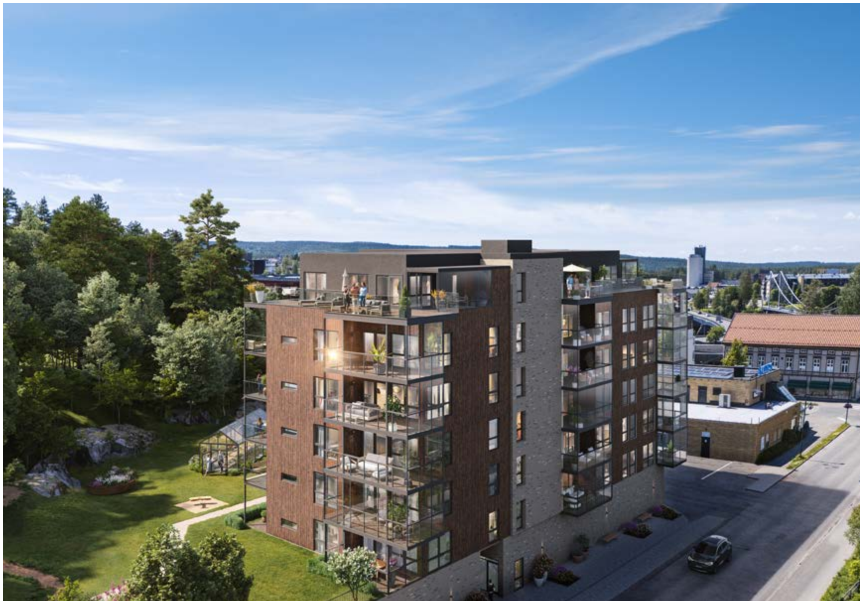
Christian Park består av 31 nye selveierleiligheter med garasjeanlegg og skjernet bakhage mot parken. Illustrasjon - avvik kan forekomme.
