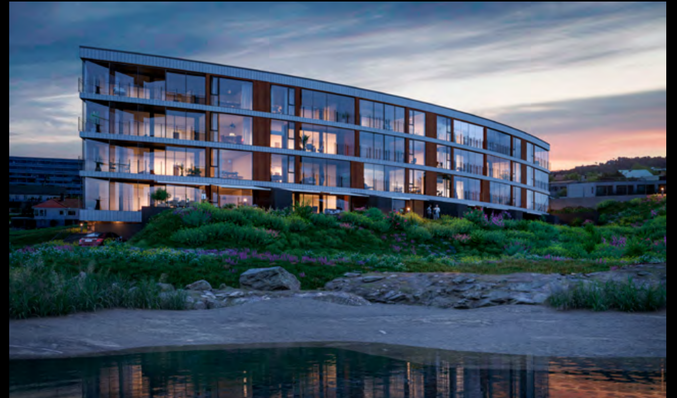
Innseilingen. 24 enheter i Haugesund. Ferdigstilt februar 2025.
