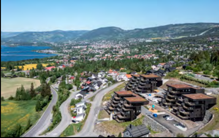
Sæterhagen Terrasse. 58 enheter i Lillehammer. Ferdigstilt 2024.
